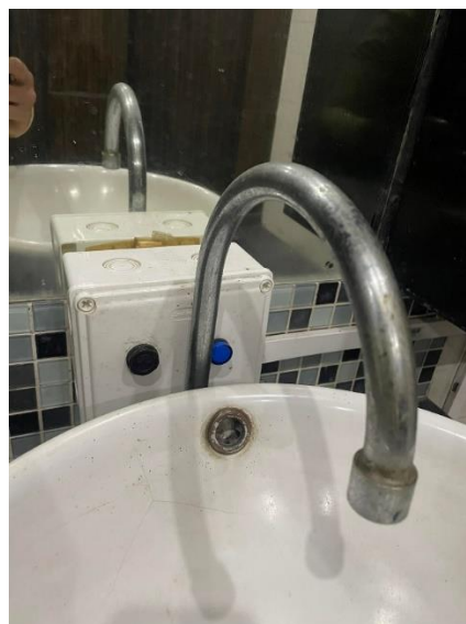
ภาพประกอบที่ 3 แสดงการติดตั้งต้นแบบอ่างล้างมืออัตโนมัติประหยัดน้ำด้วยเซ็นเซอร์ไร้สัมผัส
